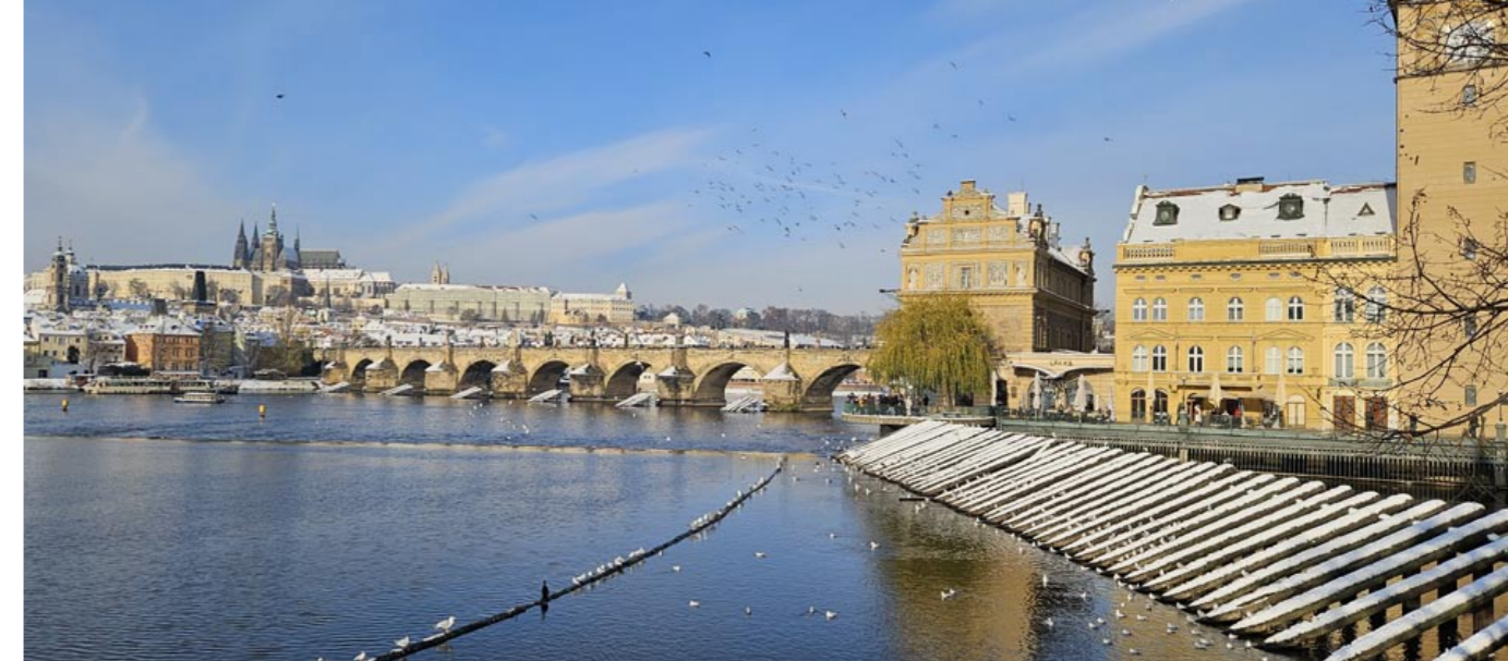
ČSVTS Novotného lávka
